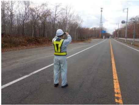
写真-1 ひび割れ路面の撮影状況
