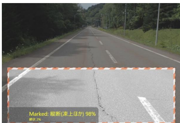
図-7 深層学習を用いた画像解析結果の例 (分類判別結果の一例：凍上ひび割れの例)
