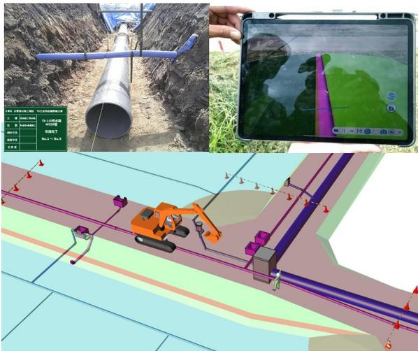
図-10 施工中のBIM/CIMモデル活用の事例
