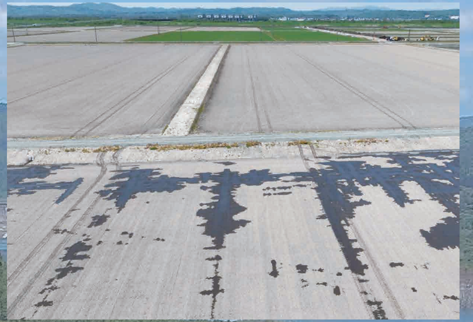
国営緊急農地再編整備事業「岩見沢北村地区」 ほ場の大区画化による地下かんがいシステムの導入
