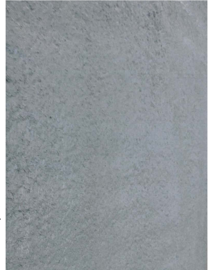
▲左官アシストによる 粗仕上げ作業後 (表面仕上げに近い水準)
