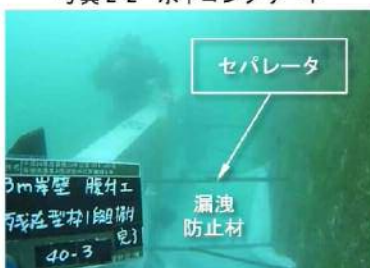
写真 2-4 セパレータ・漏洩防止材
