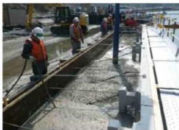
写真 2-2 水中コンクリート
