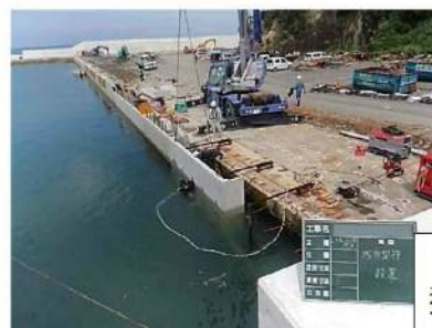
写真 1-4 本工法の施工状況
