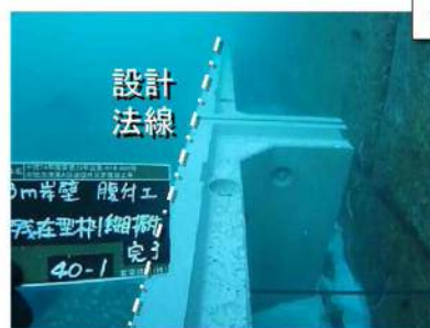
写真 1-6 残置型枠の据付状況(例)
