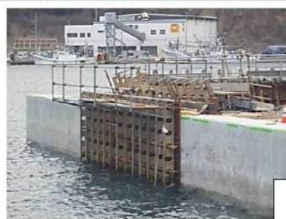
写真 1-1 従来工法の施工状況
