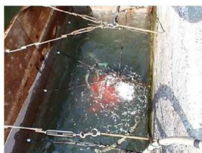
写真 1-2 鋼製型枠内の潜水作業(例)
