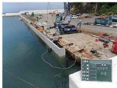
写真 1-4 本工法の施工状況
