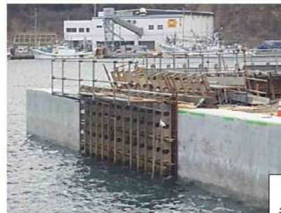
写真 1-1 従来工法の施工状況
