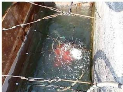
写真 1-2 鋼製型枠内の潜水作業(例)
