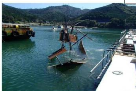
写真 1-3 鋼製型枠の被災(例)
