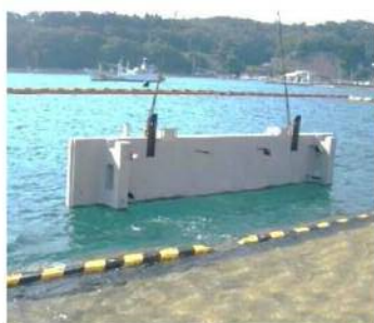
写真 1-5 残置型枠の吊り込み状況(例)
