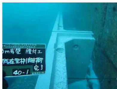
写真 1-6 残置型枠の据付状況(例)
