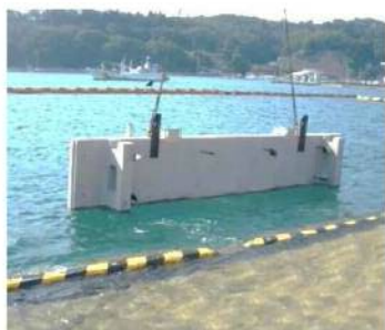
写真 1-5 残置型枠の吊り込み状況(例)
