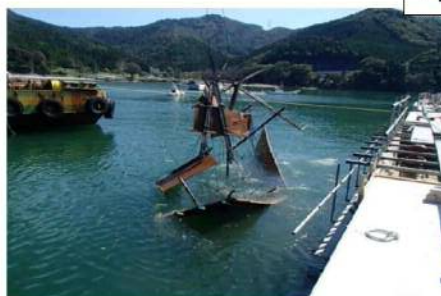
写真 1-3 鋼製型枠の被災(例)
