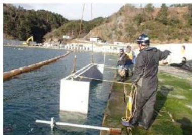
写真 2-1 残置型枠
