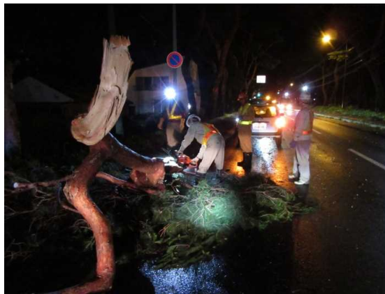
図-6 倒木撤去状況（1）
