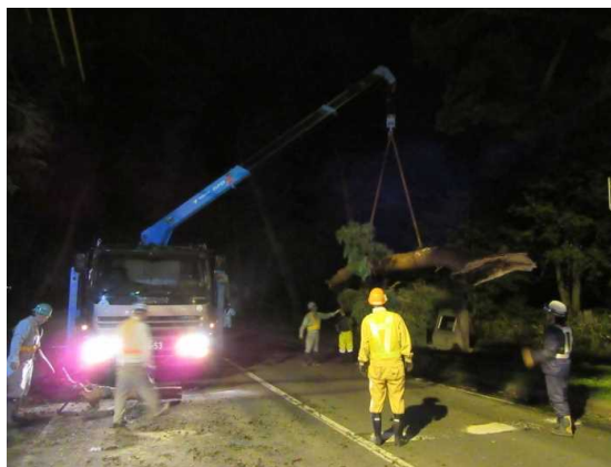
図-7 倒木撤去状況（2）
