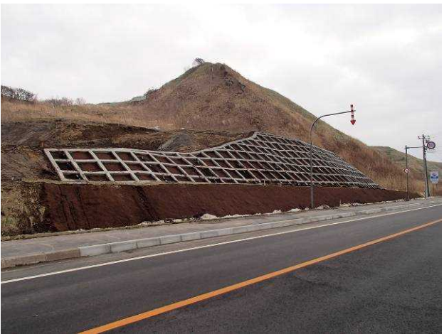
写真4 対策工完了後の状況
