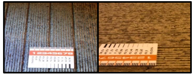
写真-4 DG工法施工後の表面の仕上がり
