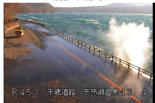
写真-10 KP46.4 付近 岸壁に打ち付ける波が強く越波を確認できる。
