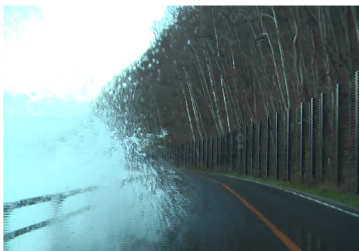
写真-8 KP45.4 付近 岸壁に打ち付ける波が強く規模の大きな越波を確認できる。 飛沫が走行車線に到達するケースもある。
