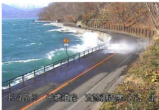
写真-11 CCTVによる越波状況の確認
