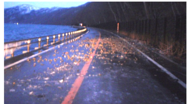
写真-4 越波による影響（湖床礫の散乱）
