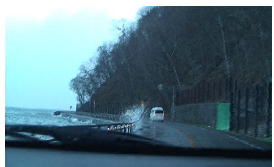
写真-9 KP46.0 付近 岸壁に打ち付ける波が強く越波を確認できるが 頻度はやや低い。
