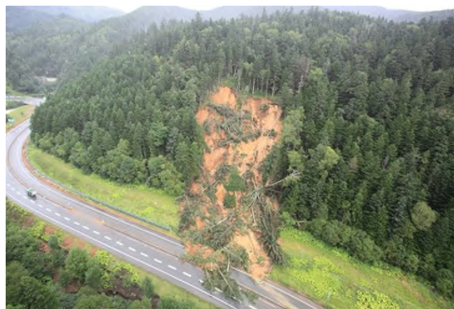
図-5 国道39号石北峠(KP=94.7)の土砂流出状況
