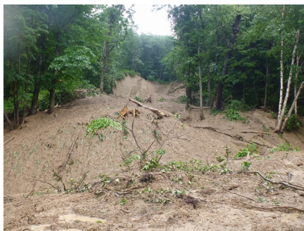
図-6 国道39号石北峠(KP=100.0)の土砂流出状況
