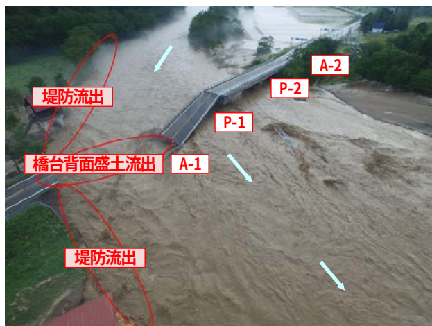
写真-5 千呂露橋 河川状況
