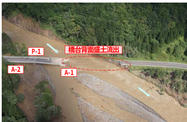
写真-9 岩瀬橋 河川状況
