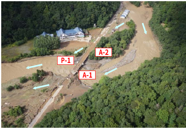
写真-7 大鷲橋 河川状況
