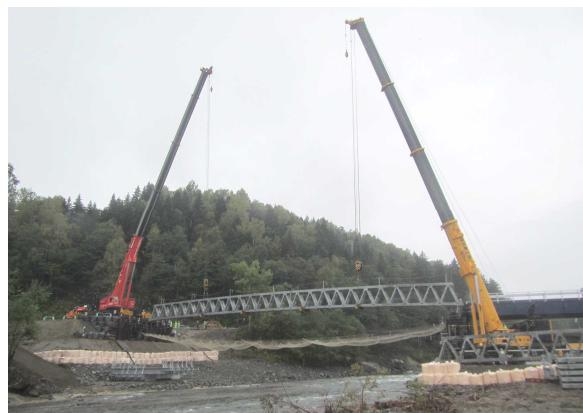
写真5: 桁架設状況（上：トラス橋、下：鮫桁部）
