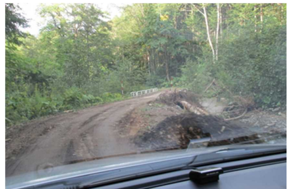
写真-6 赤林道の状況
