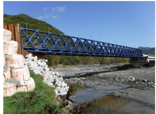
写真-9 復旧作業用仮橋完成状況
