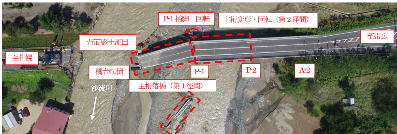
写真-3 千呂露橋損傷状況
