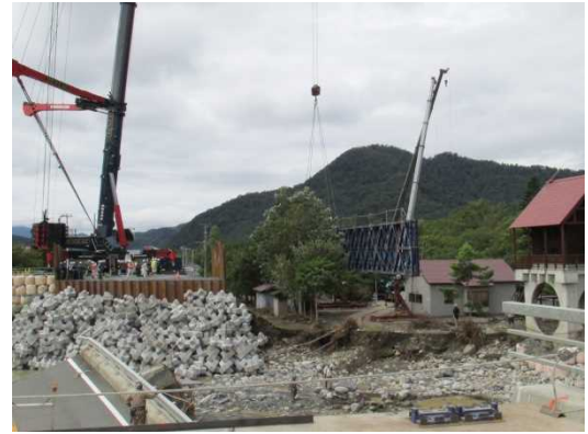
写真-8 復旧作業用仮橋架設状況
