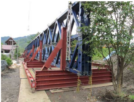
写真-7 復旧作業用仮橋地組状況
