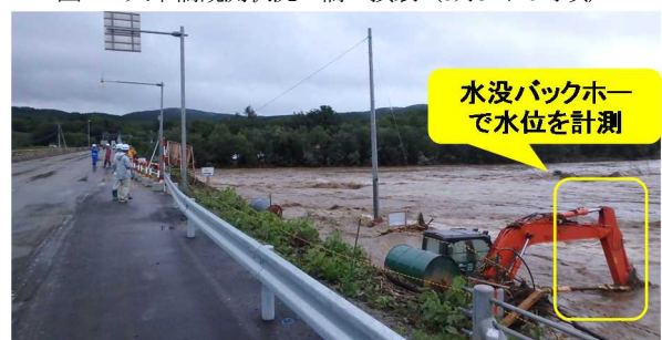
図-5 水位測定：バックホー（8月31日5時頃）
