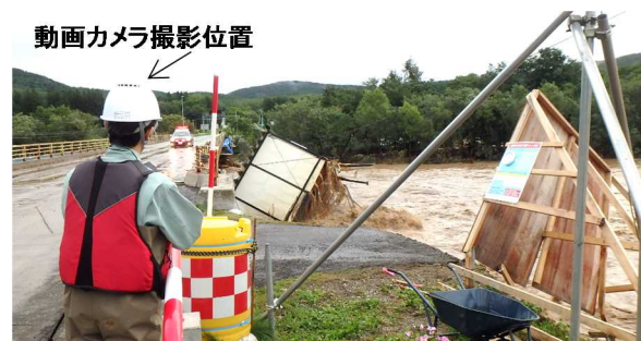
図-3 太平橋観測状況：流下物（8月31日5時頃）
