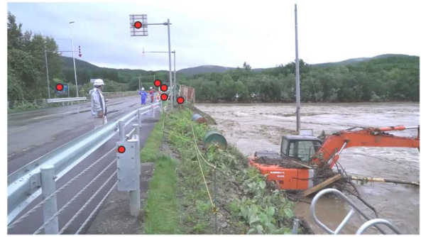
図-6 標定点の設置
