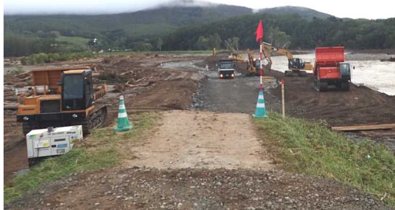
写真-3 築堤盛土状況 (9月3日7時)
