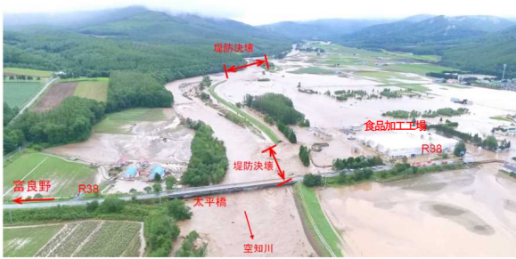
写真-1 決壊状況 (8月31日6時)
