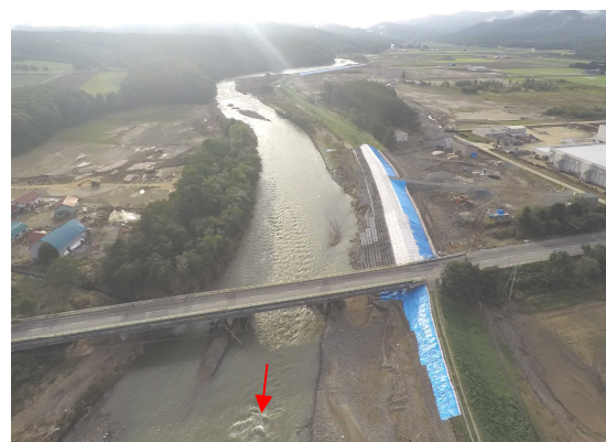
写真-9 下流決壊箇所 緊急復旧工事完了 (9月12日8時)
