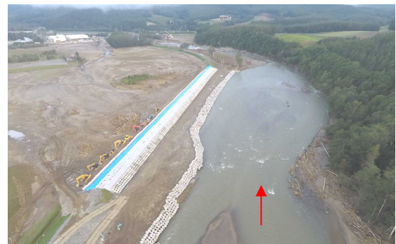
写真-5 上流決壊箇所 緊急復旧工事完了 (9月12日8時)
