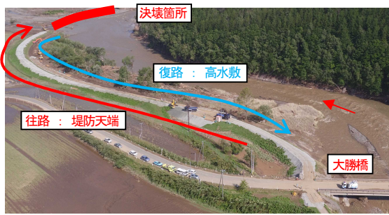
写真-2 仮設道路造成状況 (9月2日8時)
