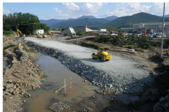
写真-8 築堤盛土状況 (9月2日16時)
