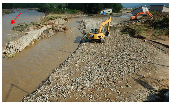
写真-7 基礎地盤整地状況 (9月1日15時)
