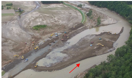
写真-4 中州掘削状況 (9月4日8時)
