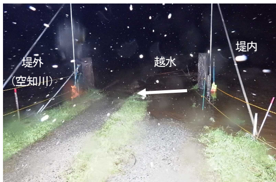
写真-5 越水状況 (8月31日2時49分) (増山建設 才田氏 提供)
