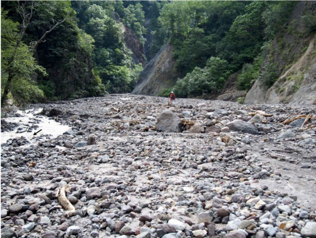
写真-4 黒岳沢川第1号えん堤から上流約1km地点 (図-2(C)地点)
