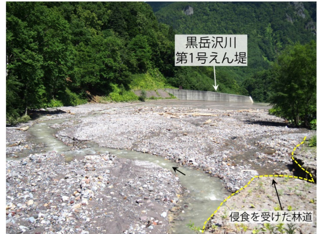
写真-2 黒岳沢川第1号えん堤上流部 (図-2(A)地点)
