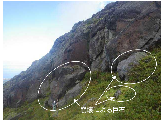
写真-1 崩壊形態状況
