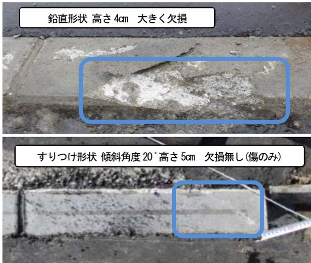
図-3 エプロン端部損傷状況
