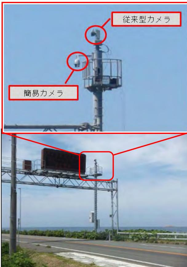
写真-1 カメラ設置状況
