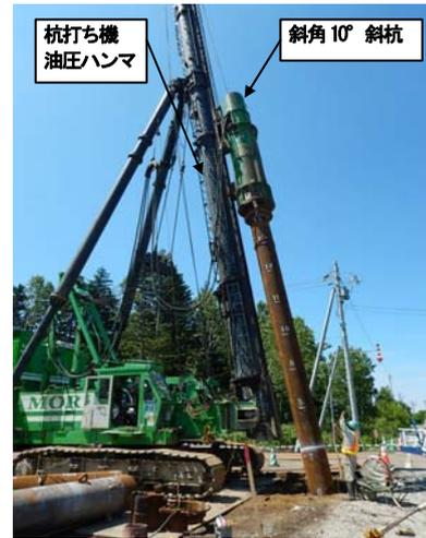
写真-1 鋼管杭打ち込み
