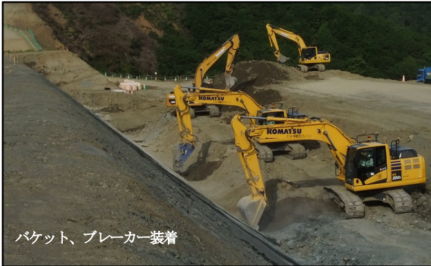
写真-6 法面整形状況 1 (丁張り無し)
