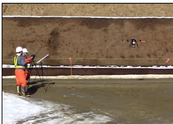
写真-3 UAV による測量実施状況
