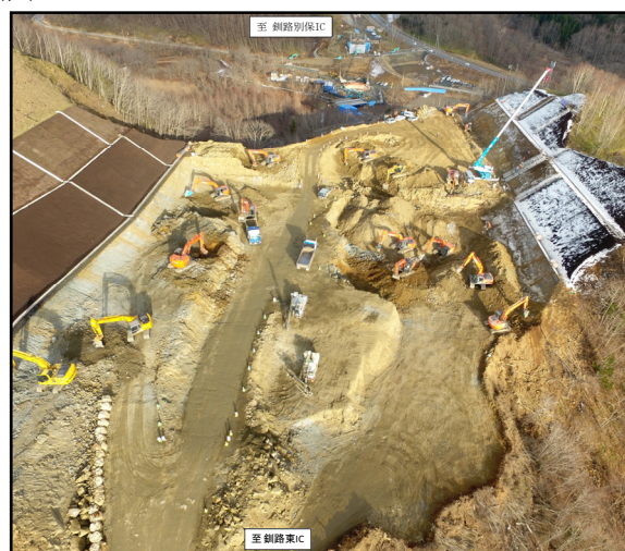
写真-2 施工状況
