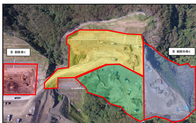
写真-1 施工箇所全景
