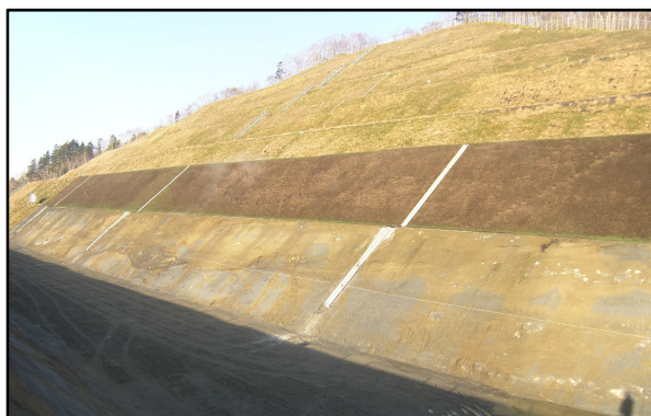
写真-9 中硬岩・硬岩の法面整形完了後
