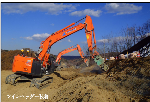
写真-7 法面整形状況 2 (丁張り無し)
