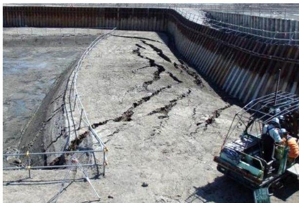
図-3 北島遊水地における鋼矢板二重締切工の変状
