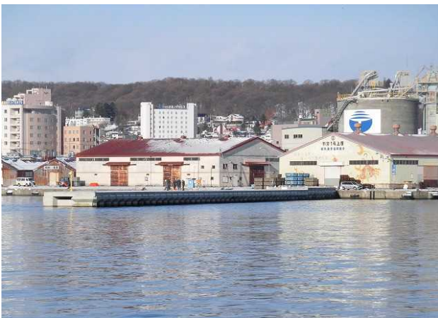
写真-3 南波除堤完成状況
