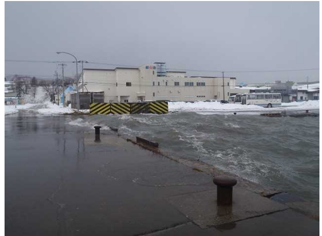
写真-4 岸壁越流状況 (H24. 12. 10)
