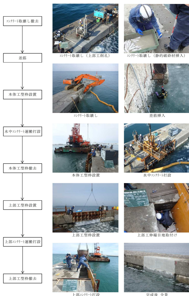
写真－4 現地施工状況（解体打替え工法）
