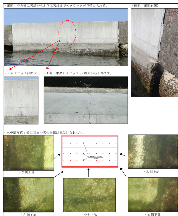
写真－7 状況写真（解体打替え工法）
