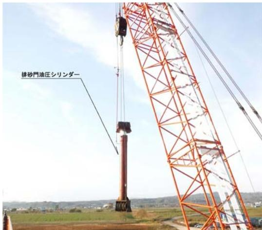
写真-3 排砂門油圧シリンダー撤去写真
