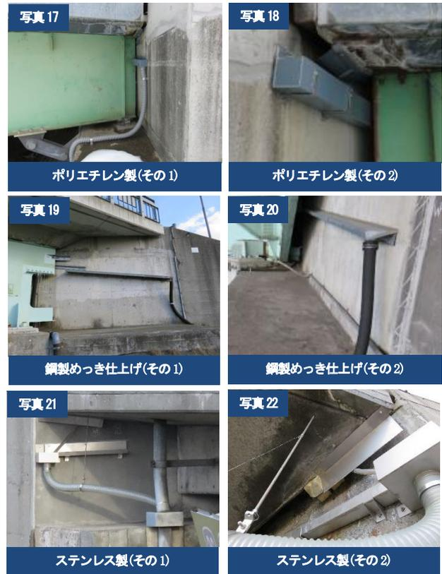
図-9 簡易排水樋設置事例
