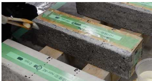
写真-1 表面強化材の塗布状況
