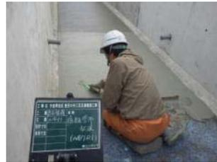
写真-7 C工法(左官工法)
