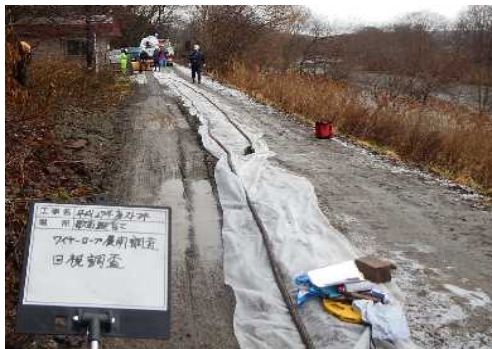
写真-4 現地展開調査全景
