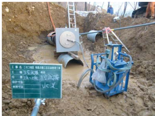
写真-4 真空気密試験状況
