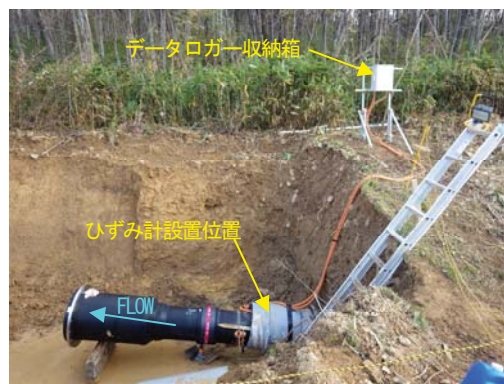
写真-5 ひずみ計設置状況 (埋戻前)
