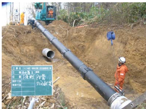
写真-3 PE管引込状況
