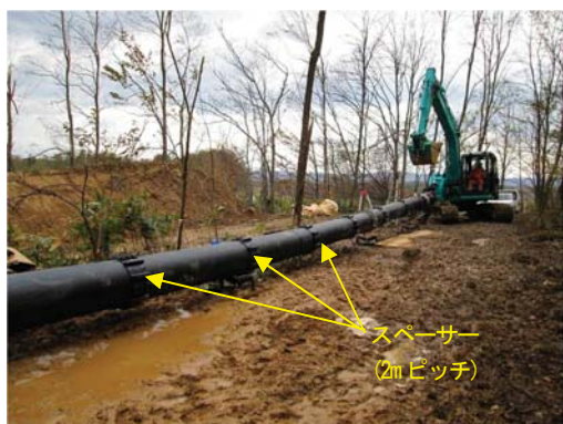
写真-2 スパース取付完了状況
