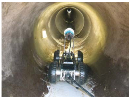
写真-1 管内カメラ調査状況 (既設管内)
