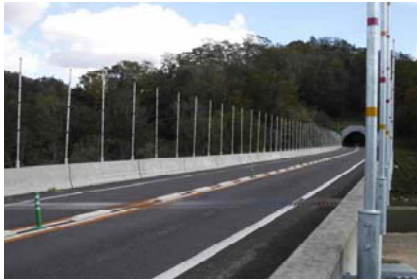
写真-4 防鳥ポールの設置状況(平成28年10月)
