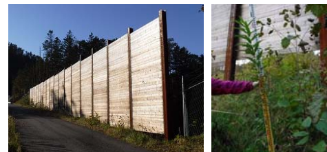
写真-3 遮蔽柵の設置状況及び木本類の生育状況 (平成28年10月)
