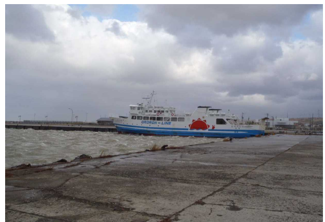
写真-2 旧岸壁への避難状況
