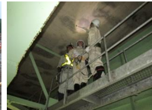
写真-9 橋梁点検実習
