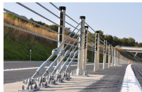
写真-5 ワイヤロープ式防護柵設置状況
