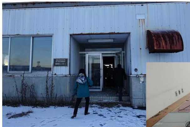
写真3. 北除雪センター
