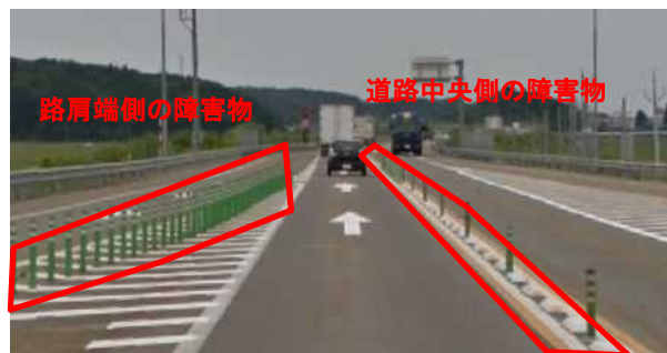
路側、道路中央側の接近注意箇所
