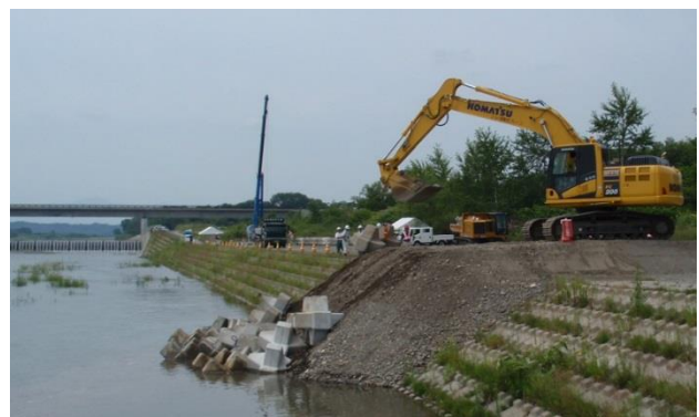
図-11 決壊締切工の作業サイクルタイム計測実験
