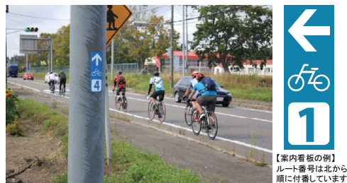
図-25 案内看板シールと設置状況(国道38号浦幌町)
