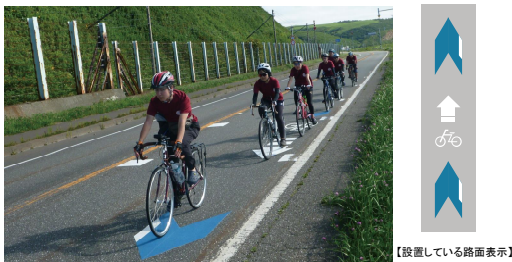
図-27 路面表示（矢羽根）と設置状況（国道238号稚内市）
