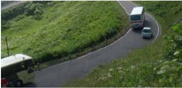
図-5 すれ違いが困難である状況（元地側）
