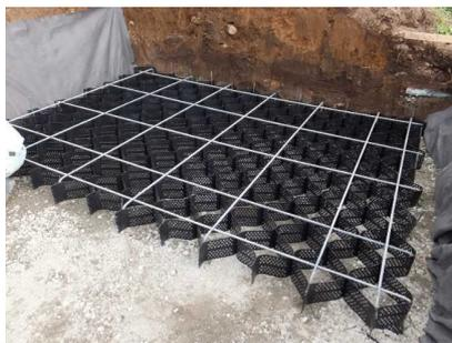
5. ジオセル敷設状況(鉄筋治具)
