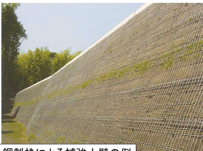
鋼製枠による補強土壁の例
