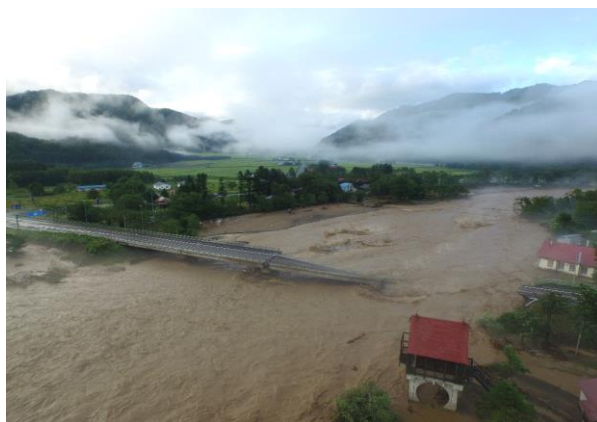
写真-1 千呂露橋落橋
