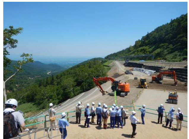
写真-9 報道機関を対象とした現地説明会（復旧作業中）
