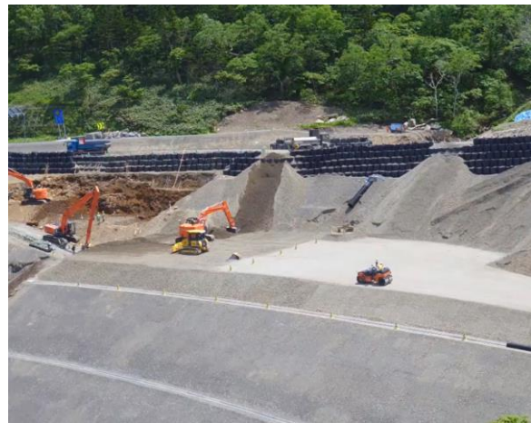
写真-4 ICT 土工による土工作業
