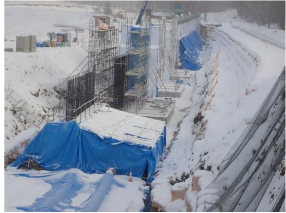
写真-3 冬期間中コンクリート擁壁施工
