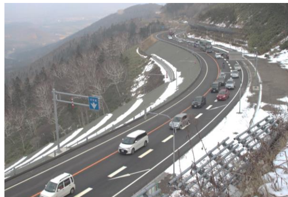
写真-5 通行止め解除後の状況
