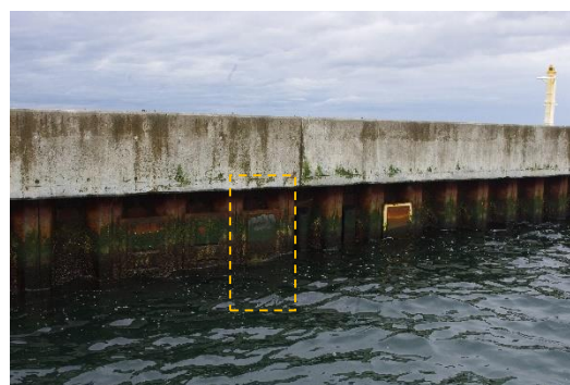
写真-5 鋼構造物の劣化事例
