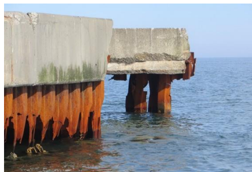
写真-5 鋼構造物の劣化事例
