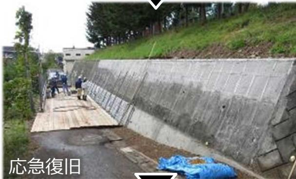
もとの擁壁は取り壊さず、上に被せて補強
