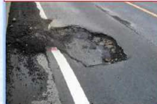
締固め度が低いだけでも、はく離が起きやすくなり、耐久性が大幅に低下してしまうのです！
