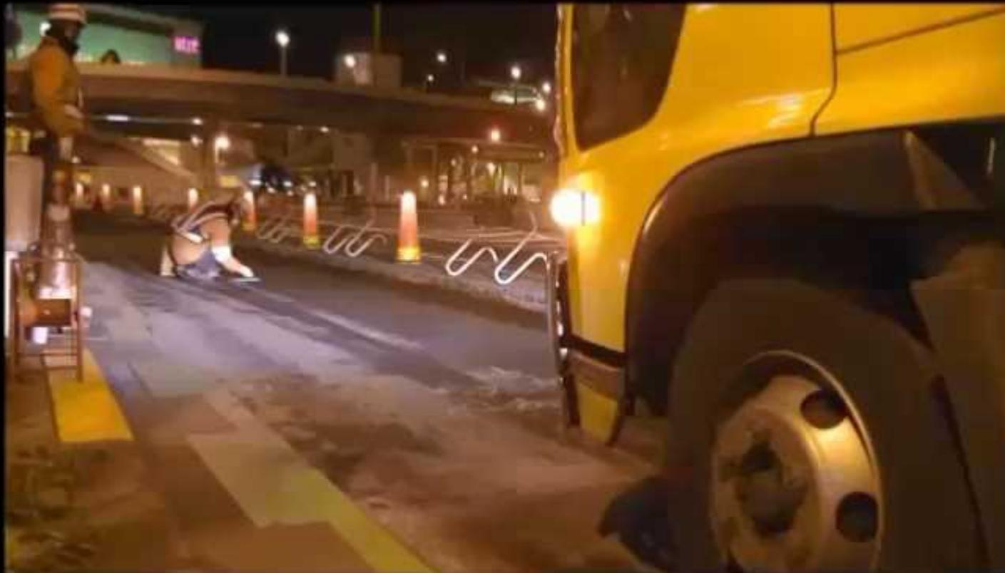
わずか数十秒で分解の後、工事用車両による剥がれやタイヤ付着なし。
