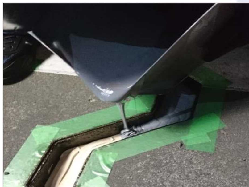
塗料による止水工法
