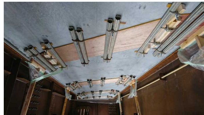
接合部型枠組立
