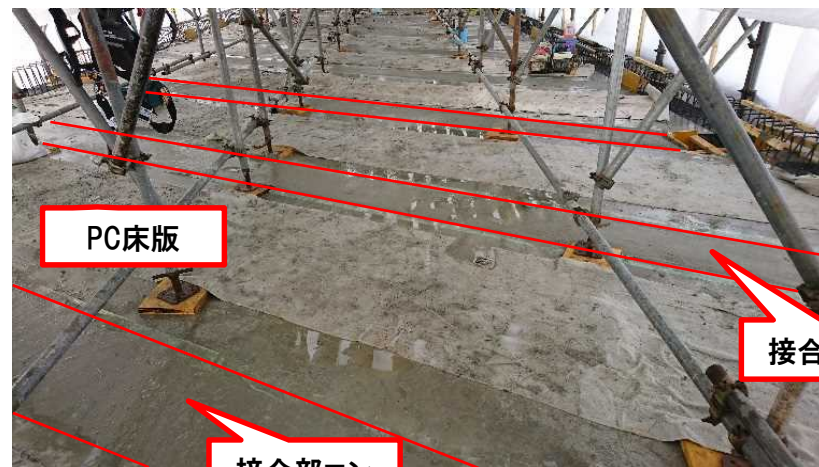
接合部コンクリート打設
