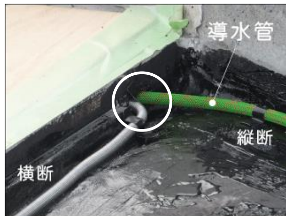
床版防水の施工後に導水管を設置。 導水管を直接接続することも出来ます。
