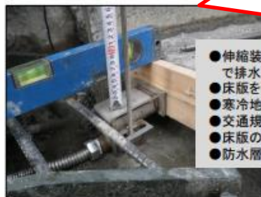
設置例(高さ確認)
