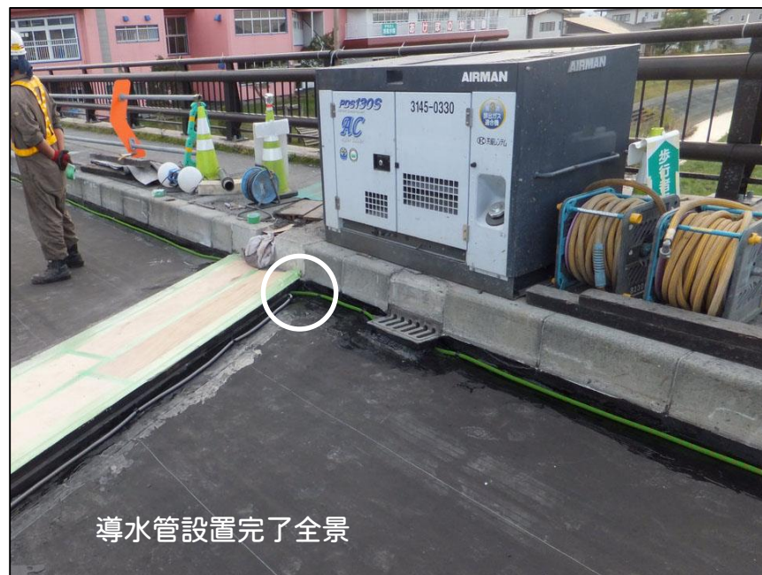
床版防水の施工後に導水管を設置。 導水管を直接接続することも出来ます。
