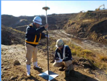
標定点設置、測量
