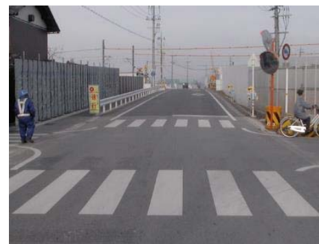
①D・Box敷設前
