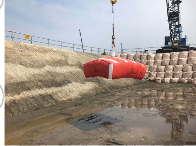
1点での吊上状況(地盤補強) カルバート基礎
