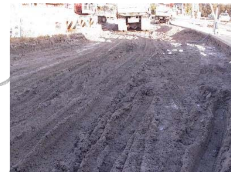
②舗装撤去(軟弱粘性地盤)
