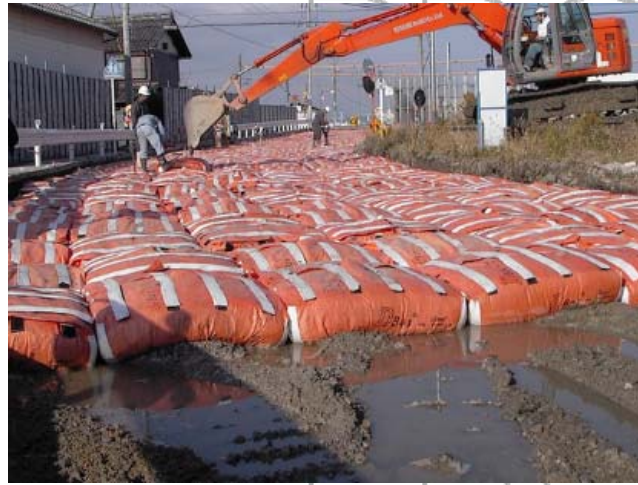
道路下層路盤への使用例 (振動対策)
