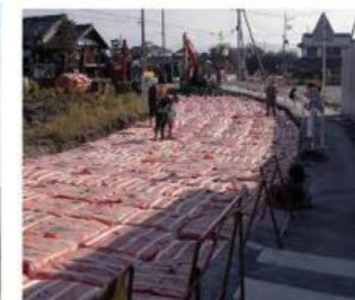
写-5.茨城県K市の市道の下層路盤にD・Boxを使用 (液状化被害低減工法)
