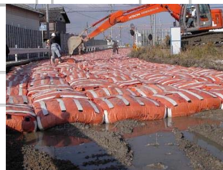
③D・Box敷設
