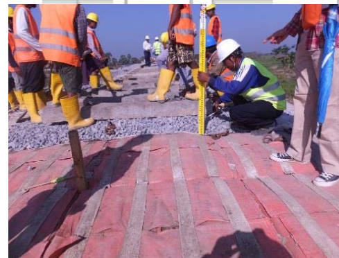
③D-Box敷設状況2017年2月
