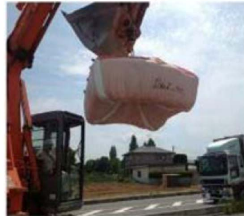
写-5.茨城県K市の市道の下層路盤にD・Boxを使用 (液状化被害低減工法)
