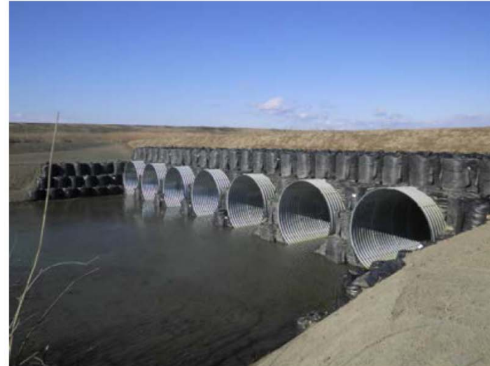
仮設水路渡河部のコルゲートパイプ完成
