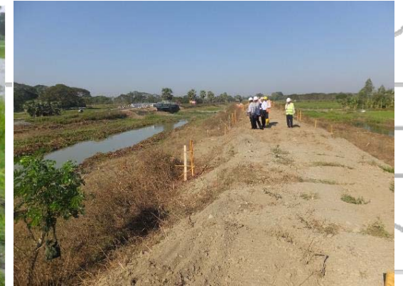
②軌道部撤去状況2017年1月
