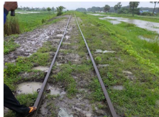
①D-Box設置前の状況2016年8月
