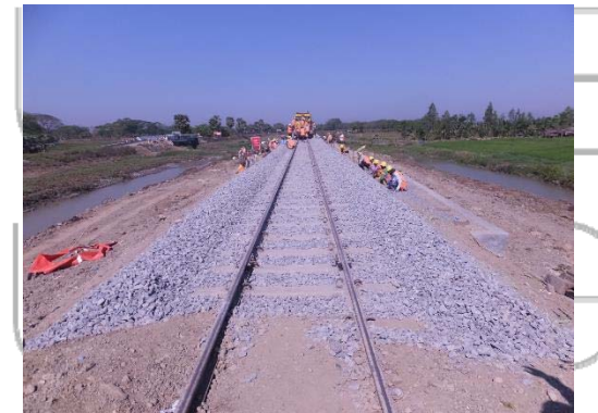
④軌道完成 2017年4月
